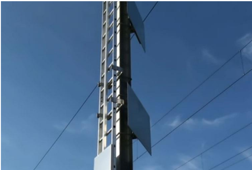
Les plaques métalliques vues de près.
